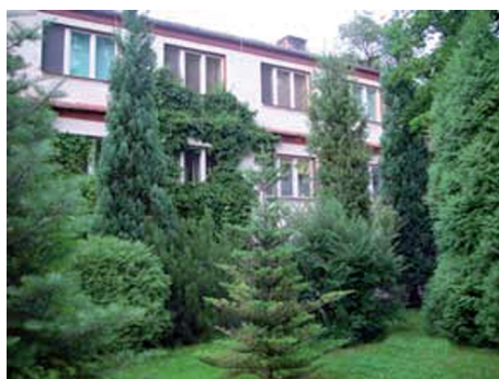
Ryc. 3. Budynek hotelu „Podzamcze”
